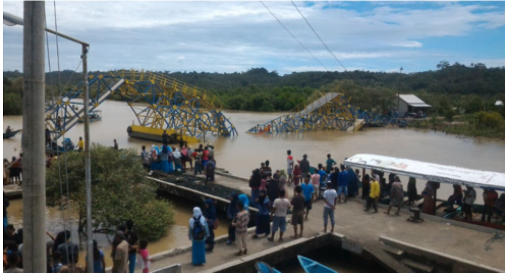
Jembatan Ambruk sekitar pukul 12.17 (Sumber foto: Warga Desa Ujung Alang)
